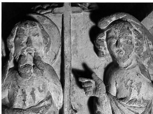
Fig. 21 et 22 Clef de voûte de la travée 15; état vers 1930 et en 2002: la comparaison montre les progrès de la dégradation.
