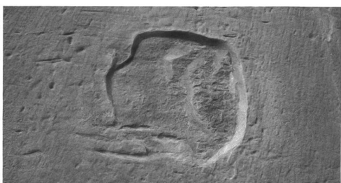
Fig. 91 et 92 Détail de la molasse extérieure avant traitement (en haut): on observe des soulèvements importants de la surface; après traitement (en bas): les éléments trop soulevés ont été éliminés, la cohérence de la molasse rétablie (bords légèrement plus sombres) et les bords renforcés par application d'un mortier à base de poudre de molasse et d'un liant aqueux à base d'un ester de silice.
