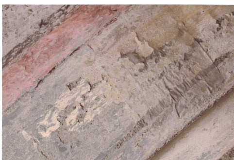
Fig. 107 Même endroit, après refixage des écailles de peinture.
