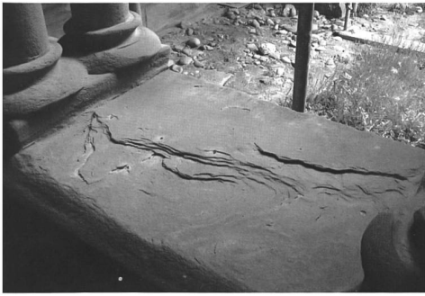
Fig. 108 Tablette en cours de traitement. Des trous ont été percés à travers les plaques de litage de la molasse, pour permettre l'injection du consolidant. Le traitement a été effectué à l'aide de seringues, mais aussi par la pose de sacs de goutte-à-goutte dont le débit était réglé pour que le produit s'écoule sans déborder.
