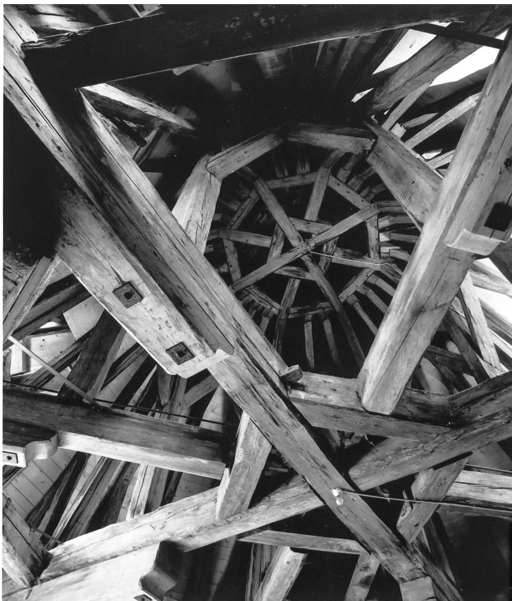
Fig. 57 Charpente de la Grande Tour, levée en 1495. Abb. 57 Dachstuhl des Hauptturms, errichtet 1495.
