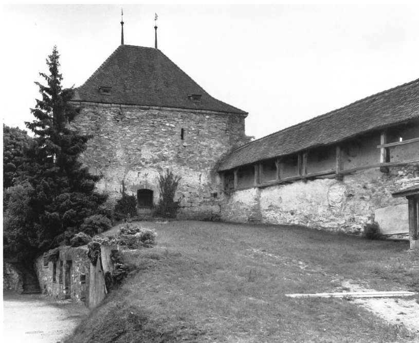
Fig. 29 Gruyères, angle sud du bourg inférieur, avec la tour comtale de Chupyâ Bârba. Les parties basses en tuf, talutées, sont comparables à celles du «donjon».
