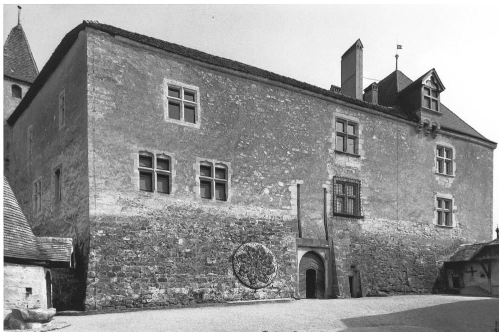
Fig. 30 Courtine occidentale, profondément remanié vers la fin du XV e siècle. Les rainures au-dessus de la porte cochère recevaient les balanciers du pont-levis franchissant le fossé comblé après 1798. Abb. 30 Die westliche Hauptmauer wurde im späten 15. Jh. stark umgestaltet. Die Schlitzte oberhalb des Wagentors nahmen die Hebelbalken der Zugbrücke auf, die über den 1798 aufgefüllten Graben führte.
