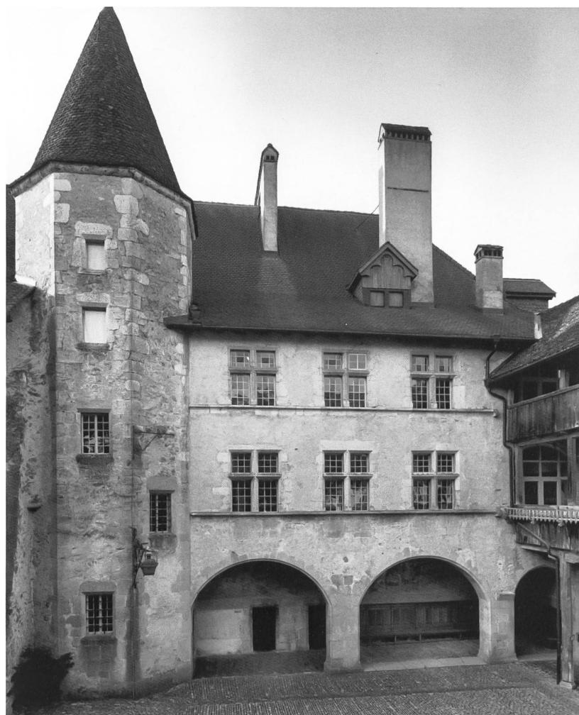
Fig. 36 Corps de logis sud et tour d'escalier. Il était peut-être prévu d'étendre la galerie maçonnée non seulement contre le mur ouest, au-dessus de l'entrée, comme en témoignent les amorces des arcades et des cordons, mais sur le pourtour de la cour intérieure ainsi unifiée. On aurait créé l'illusion d'un immense château en suggérant des corps de logis à l'arrière de cette galerie.
