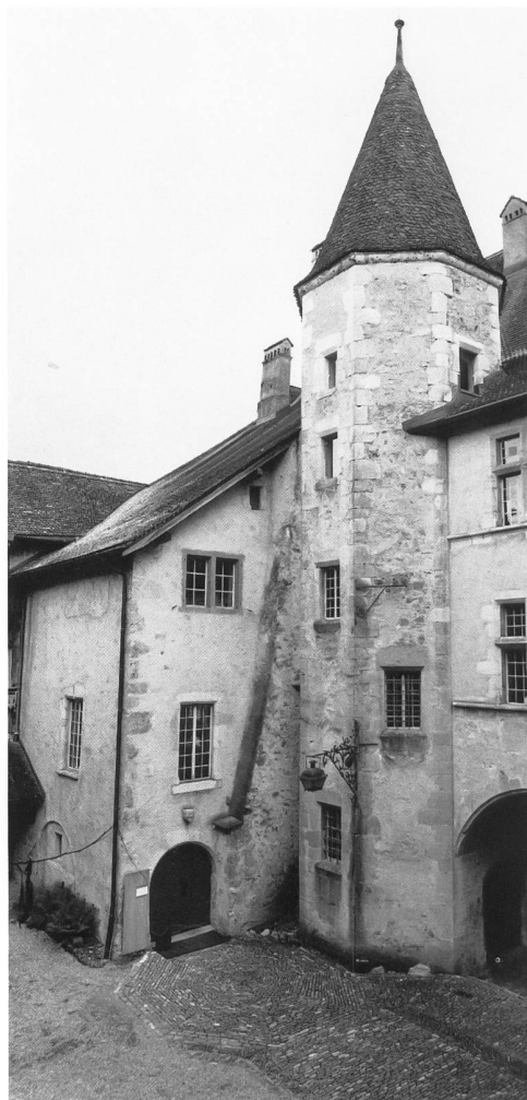
Fig. 35 Cour intérieure du côté de la tour d'escalier et de l'annexe orientale, dernière réalisation, inachevée, de l'époque comtale. Le ressaut oblique est un rhabillage de l'arrachement de la façade du corps de logis oriental, d'origine, de la fin du XIII e siècle.
