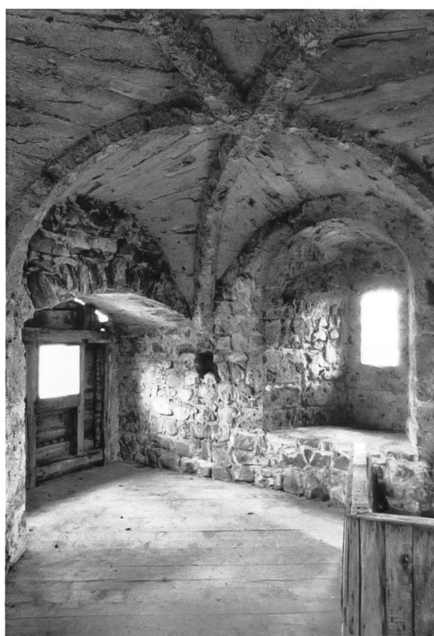
Fig. 24 Enceinte du bourg-refuge, intérieur de la tour de flanquement à cinq pans, de la fin du XV e siècle, ayant servi de tour poudrière. L'étage du couronnement est couvert d'une voûte à 5 branches. Abb. 24 Ringmauer der Fliehburg, Inneres des fünfeckigen Pulverturms, Ende 15. Jh. Fünfteiliges Rippengewölbe über dem obersten Geschoss.
