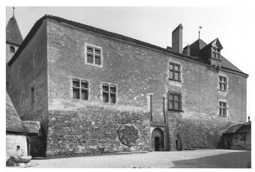
Fig. 30 Courtine occidentale, profondément remanié vers la fin du XV<sup>e</sup> siècle. Les rainures au-dessus de la porte cochère recevaient les balanciers du pont-levis franchissant le fossé comblé après 1798.
