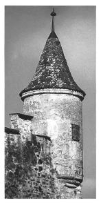
Fig. 22 Enceinte de l'esplanade ayant abrité le bourg. Ce pavillon de jardin, appelé «le Bel Air» depuis 1704, est dressé sur la partie inférieure de l'encorbellement médiéval qui a dû supporter à l'origine une tourelle défensive aux dimensions plus imposantes. Abb. 22 Die Ringmauer des Vorhofs hat einst die Burgsiedlung umfasst. Der Gartenpavillon, 1704 als «le Bel Air» erwähnt, steht über dem untern Teil des mittelalterlichen Mauervorsprungs, der ursprünglich einen Wehrturm getragen hat.
