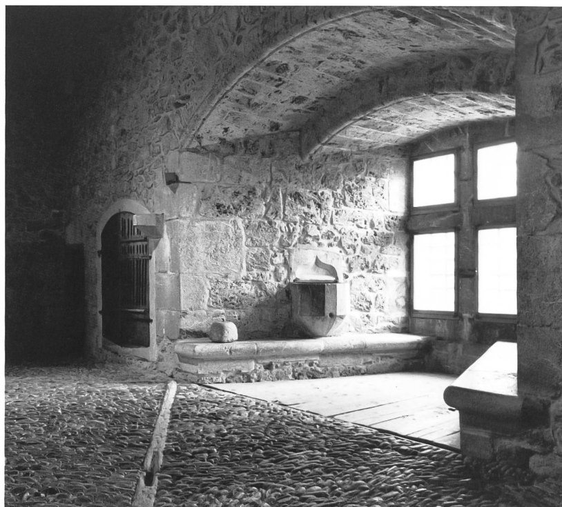
Fig. 37 Corps de logis sud, rez-de-chaussée (fig. 179-n° 0.6). Embrasure à coussiège d'une grande baie à croisée, des années 1490. A l'arrière, dans l'angle, une petite porte donne accès à la grande tour accessible à l'origine uniquement par une ouverture haute, probablement desservie par une galerie.
