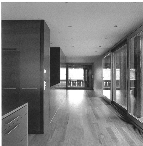
Fig. 19 Les poteaux de la structure et les planches du bardage de la façade, transformées en lames mobiles, sont visibles de l'intérieur. La conservation du caractère des façades qualifie de manière particulière les espaces intérieurs.
