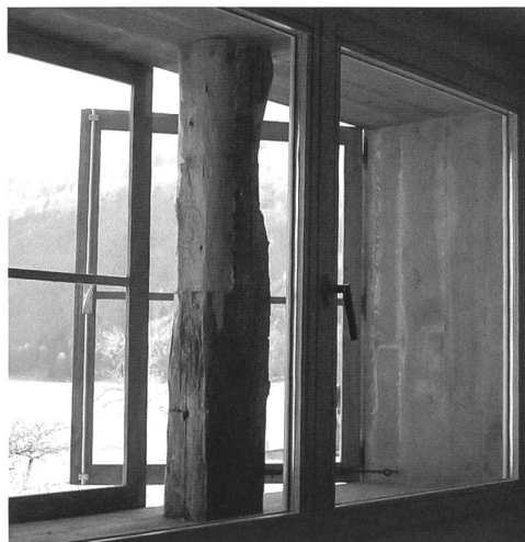
Fig. 20 La façade a une nouvelle épaisseur: l'ancienne fenêtre du pignon a été conservée, une nouvelle fenêtre a été posée dans la nouvelle façade intérieure, entre les deux, un poteau de la structure du pan de bois de la façade pignon est visible.
