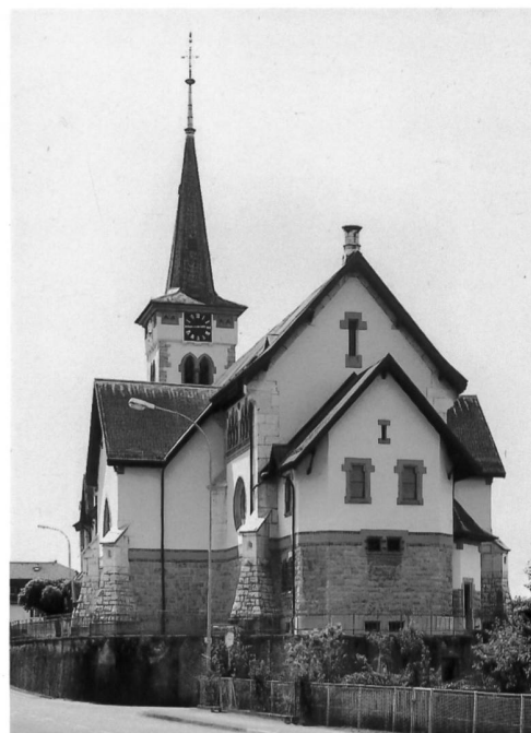
Fig. 10 Vue de l'est avec le chœur et la sacristie.
