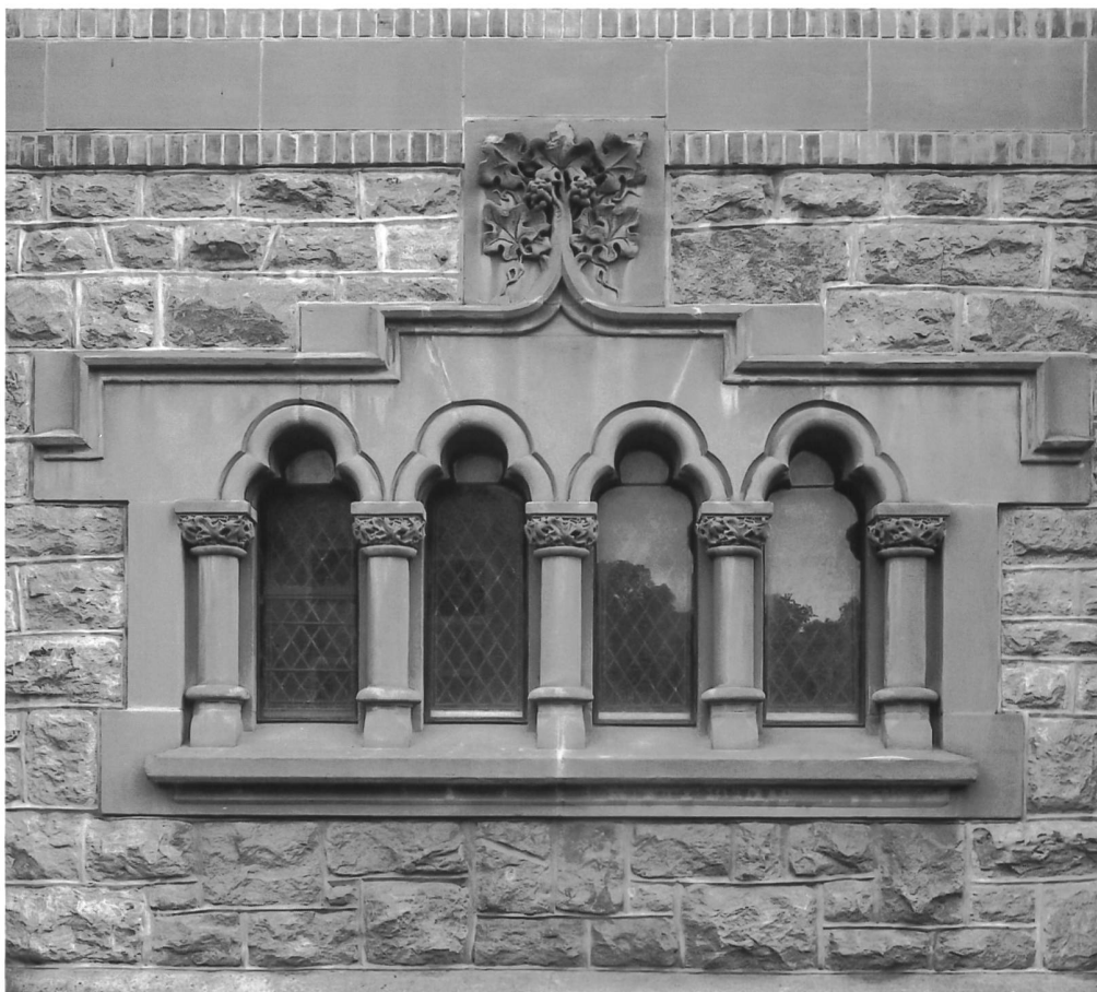
Fig. 14 Le quadriplet éclairant la dernière travée de la nef. – A l'éclectisme des formes, répond un remarquable éclectisme des matériaux assemblés et mis en œuvre avec une virtuosité rare.
