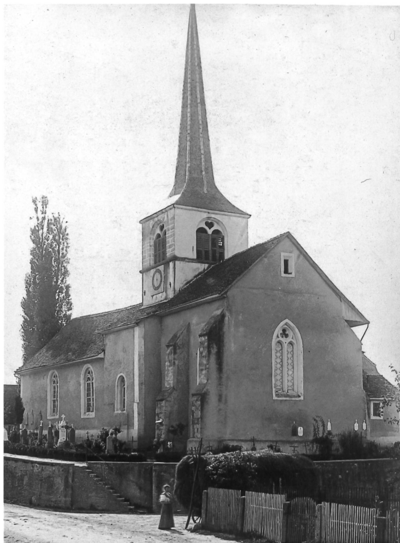
Fig. 2 L'ancienne église vue de l'est, avec l'ancien chœur gothique du XIV e siècle. Cliché du professeur Joseph Zemp, probablement 1901.
