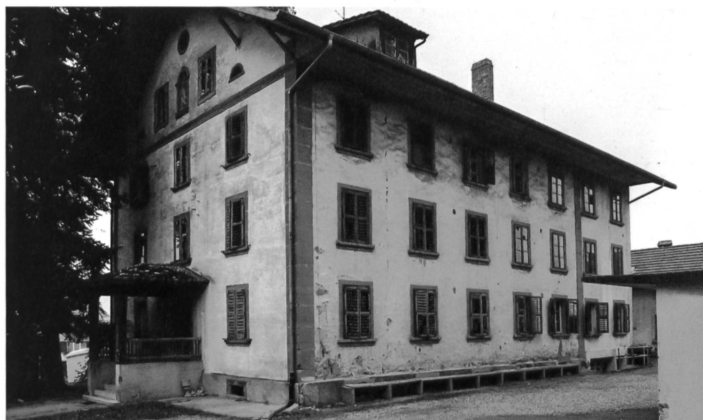
Abb. 2 West- und Südfassade von 1885 mit dem Erweiterungstrakt (zwei Achsen) von 1902.
