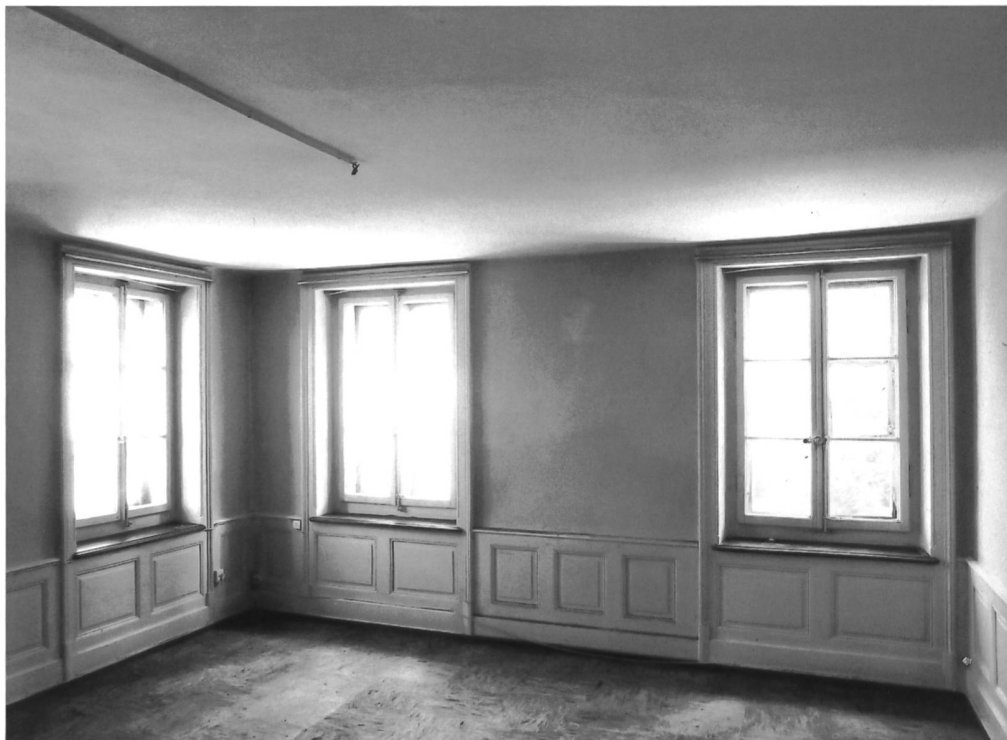
Abb. 5 Innenansicht eines Zimmers des Erweiterungstraktes von 1902. Das aus der Bauzeit datierte kassettierte Kniestäfer und die originalen Fenster weisen auf solid ausgeführte Schreinerarbeiten hin.
