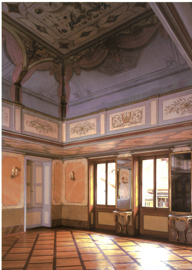
Fig. 4 Vue de l'angle de la salle, du côté des fenêtres et de la fausse galerie – Les différents niveaux du décor sont bien visibles: de bas en haut, décor original de panneaux en «stucco lustro», garde-corps avec peintures décoratives refaites au XX e siècle, galerie en trompe-l'œil et plafond avec décor original de 1850.
