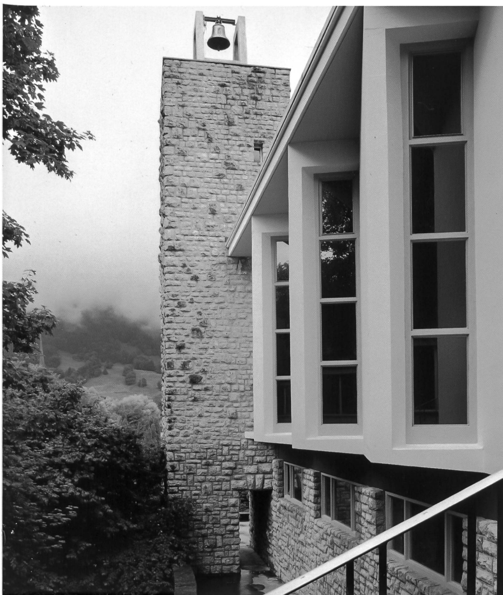
Fig. 4 Vue de la façade latérale de la chapelle de la Salette de Bouleyres, après restauration – Le socle et le clocher revêtus de pierres naturelles, qu'on a interprétés comme une concession aux régionalismes de l'époque, renforcent la modernité de la façade constituée de plaques de béton posées en biais ménageant des fentes, à la manière de branchies.
