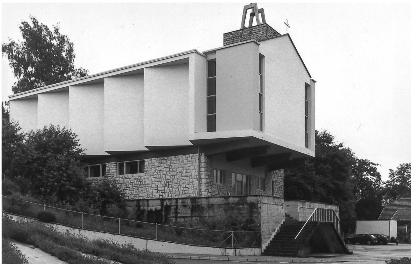
Fig. 1 La chapelle de la Salette de Bouleyres, à l'entrée de Broc – Le socle massif qui devait abriter la halle de gymnastique du collège, avec son parement de calcaire, tranche avec la chapelle aux découpes géométriques très franches. Le cube de la nef découpé en branches se prolonge par un massif en encorbellement abritant la sacristie, portée par les poutres en béton affirmées comme articulation entre les volumes. Le retournement subtil de la corniche de la nef en plateau du chevet met en valeur le sanctuaire comme présenté au fidèle par une main abstraite et monumentale. L'effet de coulisse des parois du chevet et les fentes verticales dans les angles donnent à ce motif en suspension une présence et un impact qui n'ont jamais été compris, l'évêque n'ayant pas osé, selon Jeanne Bueche, venir affronter la population locale pour consacrer officiellement l'église.
