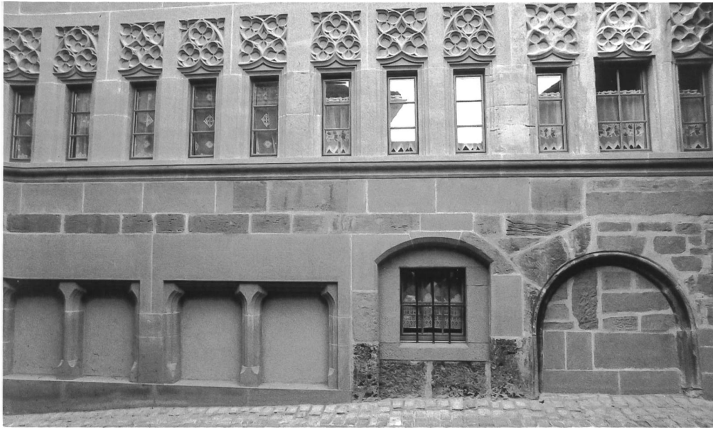
Abb. 9 Westfassade, Detailansicht der Blendmasswerke nach der Restaurierung von 1997/98.
