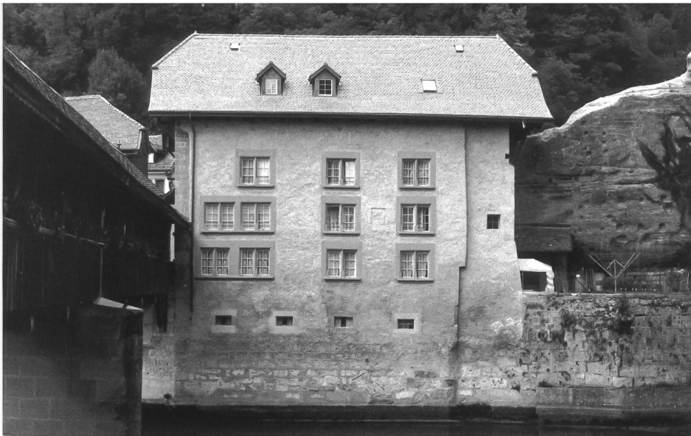
Abb. 6 Südfassade nach der Restaurierung von 1997/98.
