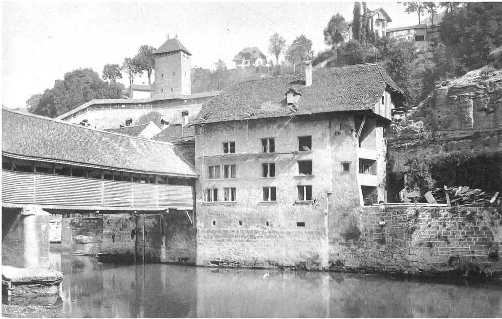
Abb. 2 Historische Ansicht mit Bernbrücke und Haus Mooses (Südfassade) während der Restaurierung von 1923/24.
