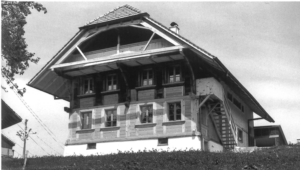
Abb. 2 Altbauteil, mit renovierter Südfassade und teilweise ersetzttem Holzwerk.
