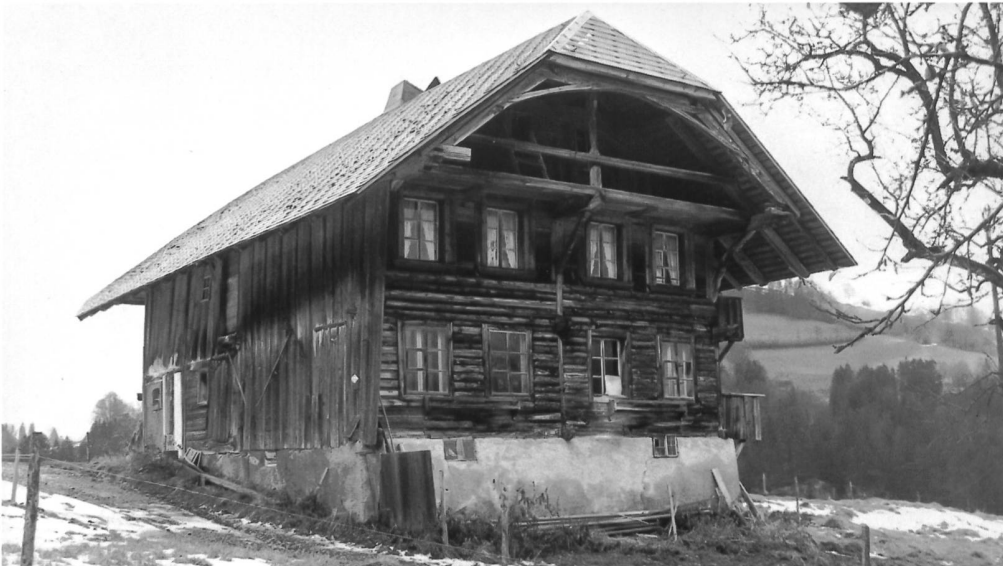
Abb. 1 Südfassade vor der Renovation.
