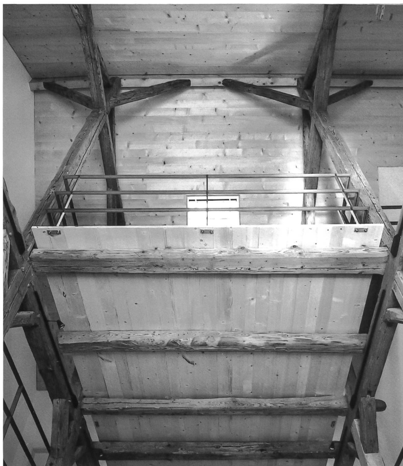
Fig. 18 La pose d'un plancher sur un ancien solivage de la grange offre une surface que le programme, dans sa définition préalable, n'exigeait pas.
