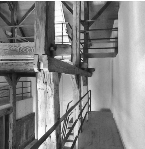
Fig. 15 Les assemblages de la structure porteuse de la grange attestent l'ancienneté de la construction.
