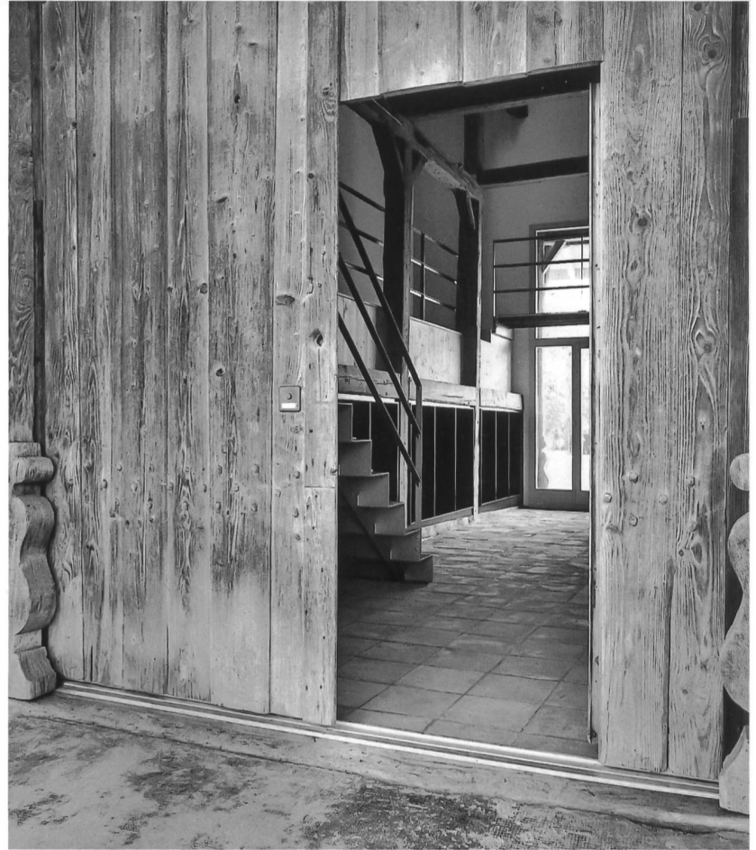
Fig 16 L'ancienne porte de grange, côté route, a été conservée et doublée de l'intérieur. La porte du logement y a été aménagée.
