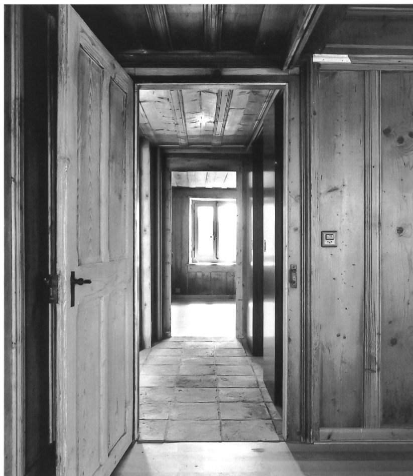
Fig. 2 Vue traversante de l'ancien logis au rez-de-chaussée – Les plafonds en bois, maintenus en place et soigneusement protégés, ont été utilisés comme coffrage. Les cloisons conservées ont été réparées en récupérant des éléments des cloisons supprimées.
