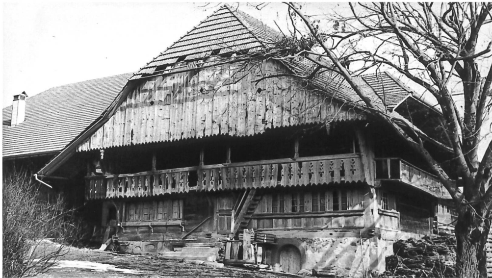
Fig. 3 L'ancienne ferme n° 142 de Medewil, à St-Ours, démolie à la fin des années 1970 – Seul un changement d'affectation pourrait assurer le sauvetage des plus beaux témoins de l'architecture rurale fribourgeoise.
