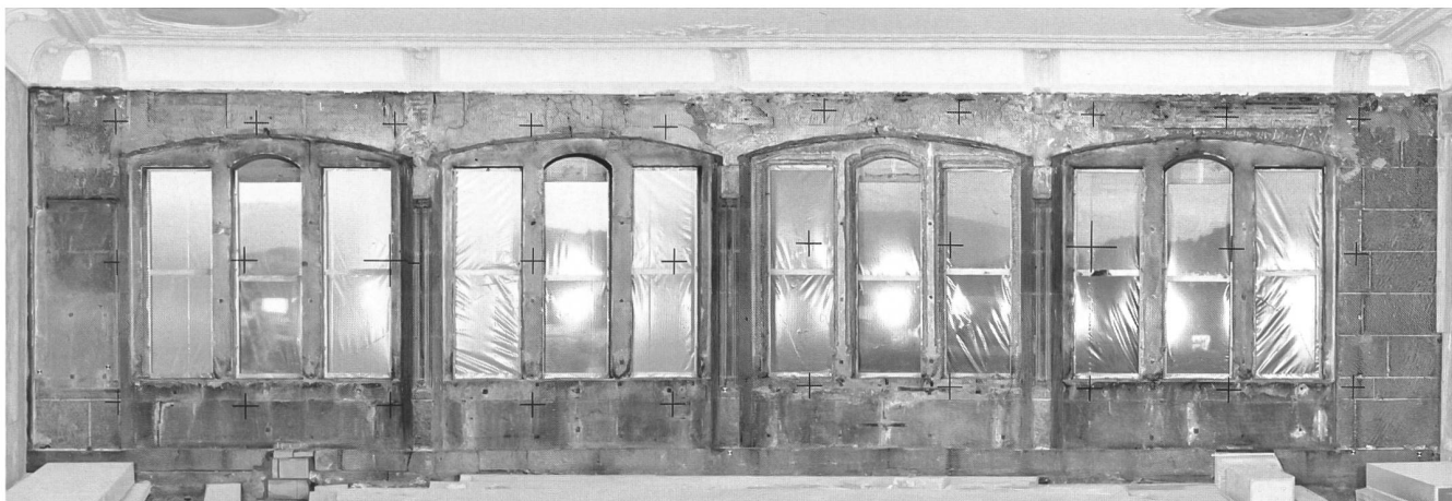
Fig. 5 Orthophoto de la façade sud sans lambris. Le ressaut horizontal situé juste au-dessus des voûtains marque le niveau du plafond du XVI e siècle. Les éléments laissés en clair n'ont pas été redressés.
