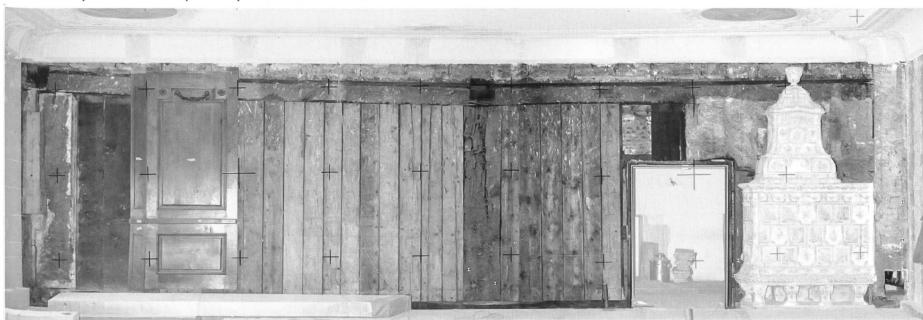
Fig. 6 Orthophoto de la cloison ouest sans lambris. La paroi du XVI e siècle est visible à gauche du panneau subsistant. Dans la partie supérieure, la rainure marque le niveau du plafond primitif et, au centre, la trace du sommier est nettement visible.
