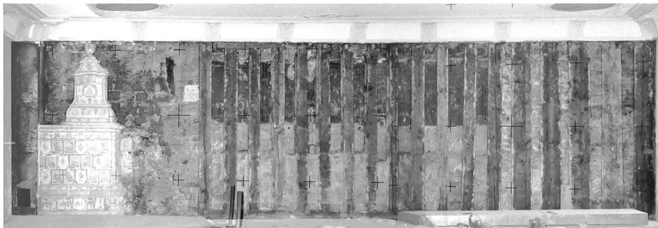
Fig. 4 Orthophoto de la paroi est sans lambris. A noter au centre les restes d'un décor peint de panneaux en trompe-l'œil. La limite inférieure de ce décor marque la hauteur de la boiserie initiale.
