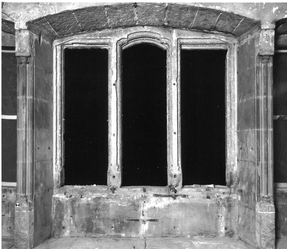
Fig. 3 Une des fenêtres triples de la façade sud, vue de l'intérieur après enlèvement du plâtras. Malgré l'arasement des éléments saillants et le piquage du voûtain pour la pose des cadres de fenêtres, cette baie a conservé l'harmonie de ses proportions, l'élégance de ses moulures et la finesse de sa stéréotomie. A noter dans les angles supérieurs le rabattement des moulures qui marque la forme initiale du voûtain.
