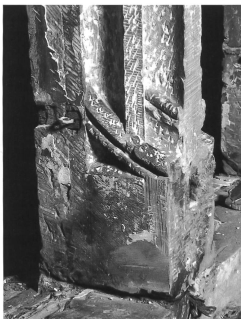
Fig. 8 Façade sud, détail des moulures et du congé d'un des meneaux du XVI e siècle.
