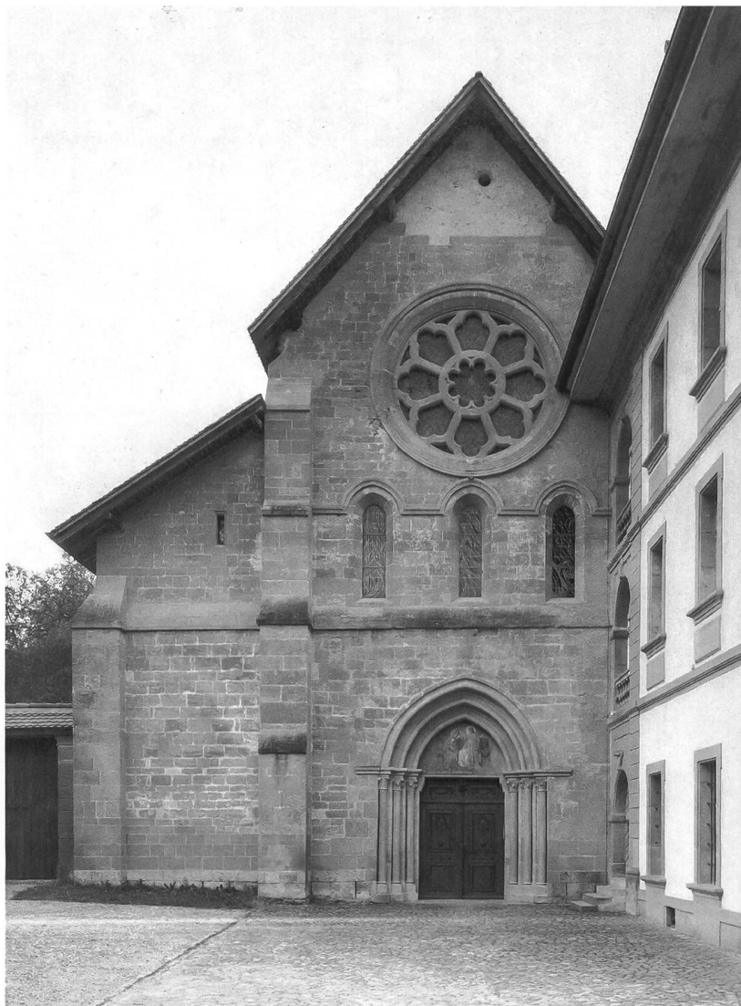
Fig. 24 La façade gothique de l'église.
