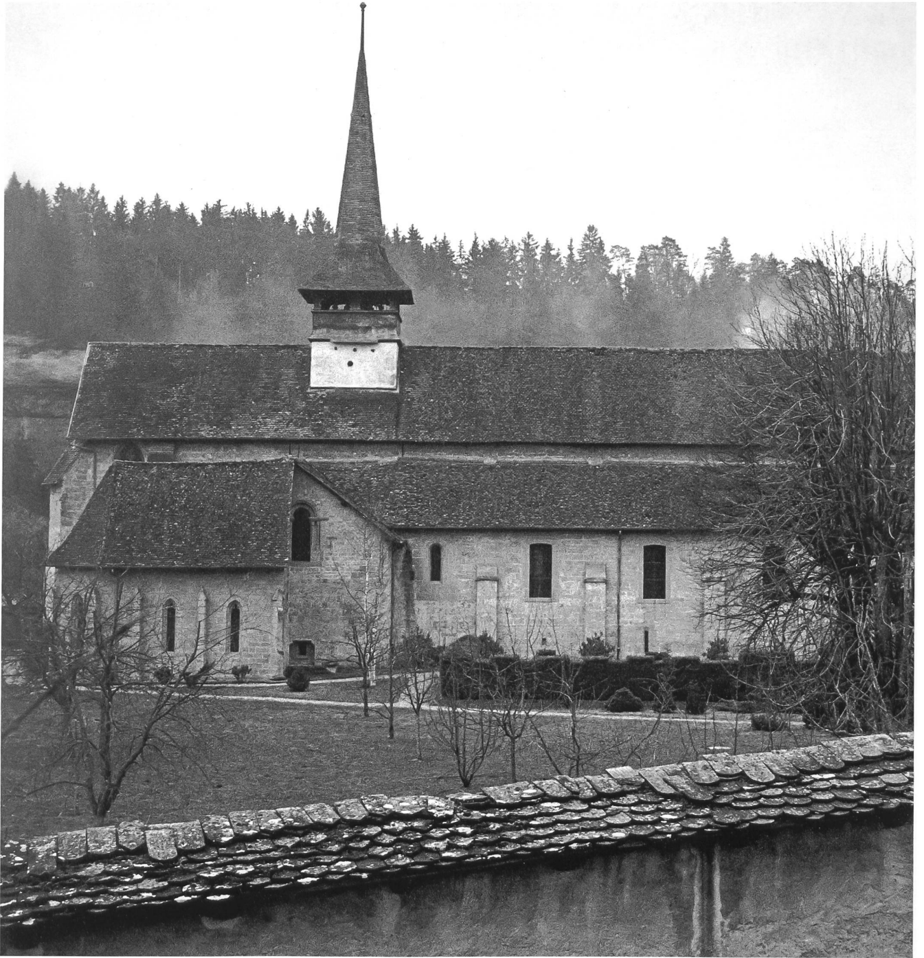
Fig. 16 L'église vue du nord.
