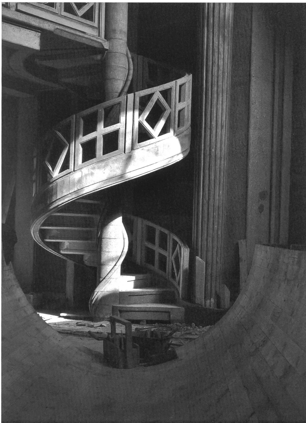
Fig. 56 L'escalier en colimaçon de la tribune, élément préfabriqué réalisé par la firme A. Bangerter de Lyss - Au sol, l'un des coffrages utilisés pour la réalisation des voiles transversaux des collatéraux.
