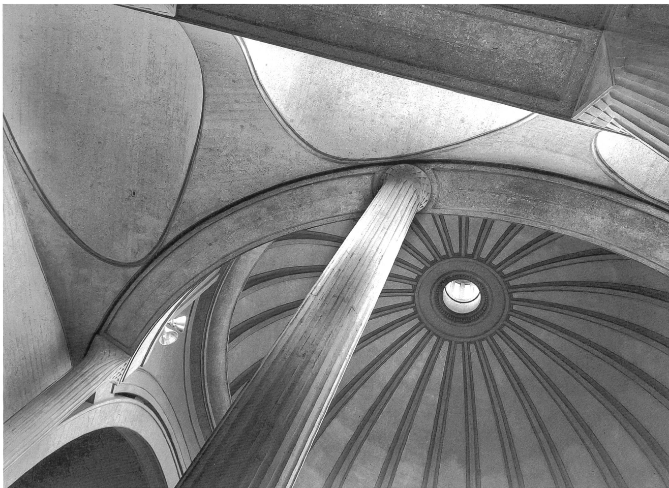
Fig. 54 Contre-plongée à la rencontre des collatéraux et du chevet, montrant la complexité des pénétrations des voûtes.
