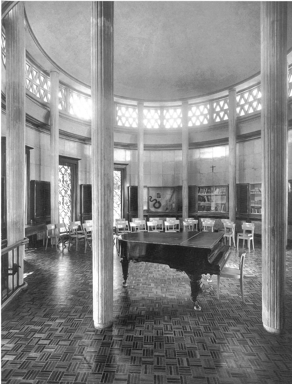
Fig. 58 Le pavillon de musicologie de l'Université de Miséricorde. - Cet espace terminé par un tambour ajouré de claustras, couvert d'une calotte en béton portée par une colonnade, constitue le prototype de la couverture envisagée d'abord pour le chœur du Christ-Roi.
