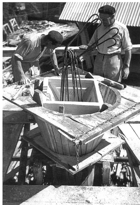
Abb. 52 Arbeiter beim Setzen der Gussform für die Kapitelle des Schiffs von Antoine Claraz, Frühling 1952.
