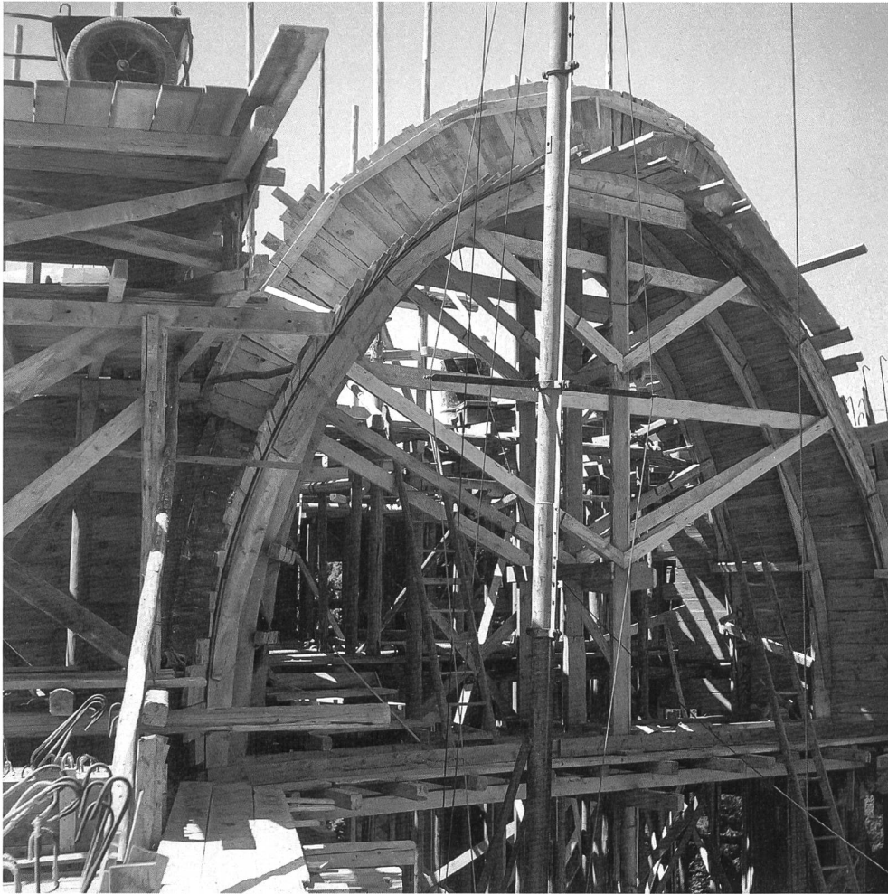
Abb. 51 Die Verschalung des Chorbogens, August 1952.
