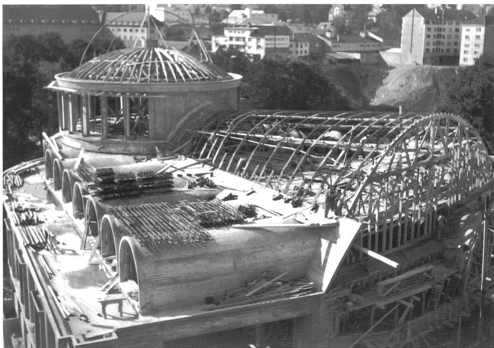
Fig. 39 Mise en place des cintres métalliques de la grande voûte, octobre 1952. – Sur les cintres de la coupole initialement prévue, on voit le gabarit de la nouvelle coupole hémisphérique. Le chevet ayant été imaginé au milieu d'un jardin à la française limité par des immeubles, Honegger l'avait conçu en conséquence. Antognini estimait qu'il fallait surélever la coupole – posée sur un tambour et non sur des claustras comme le proposait l'avant-projet –, pour qu'elle fût visible du boulevard, d'autant plus qu'on reprochait volontiers à l'église son peu d'élévation. Honegger n'insista pas et choisit l'une des propositions élaborées par l'architecte fribourgeois. La solution retenue n'est pas satisfaisante, la coupole étant quoiqu'il en soit toujours trop basse pour se détacher de l'église.
