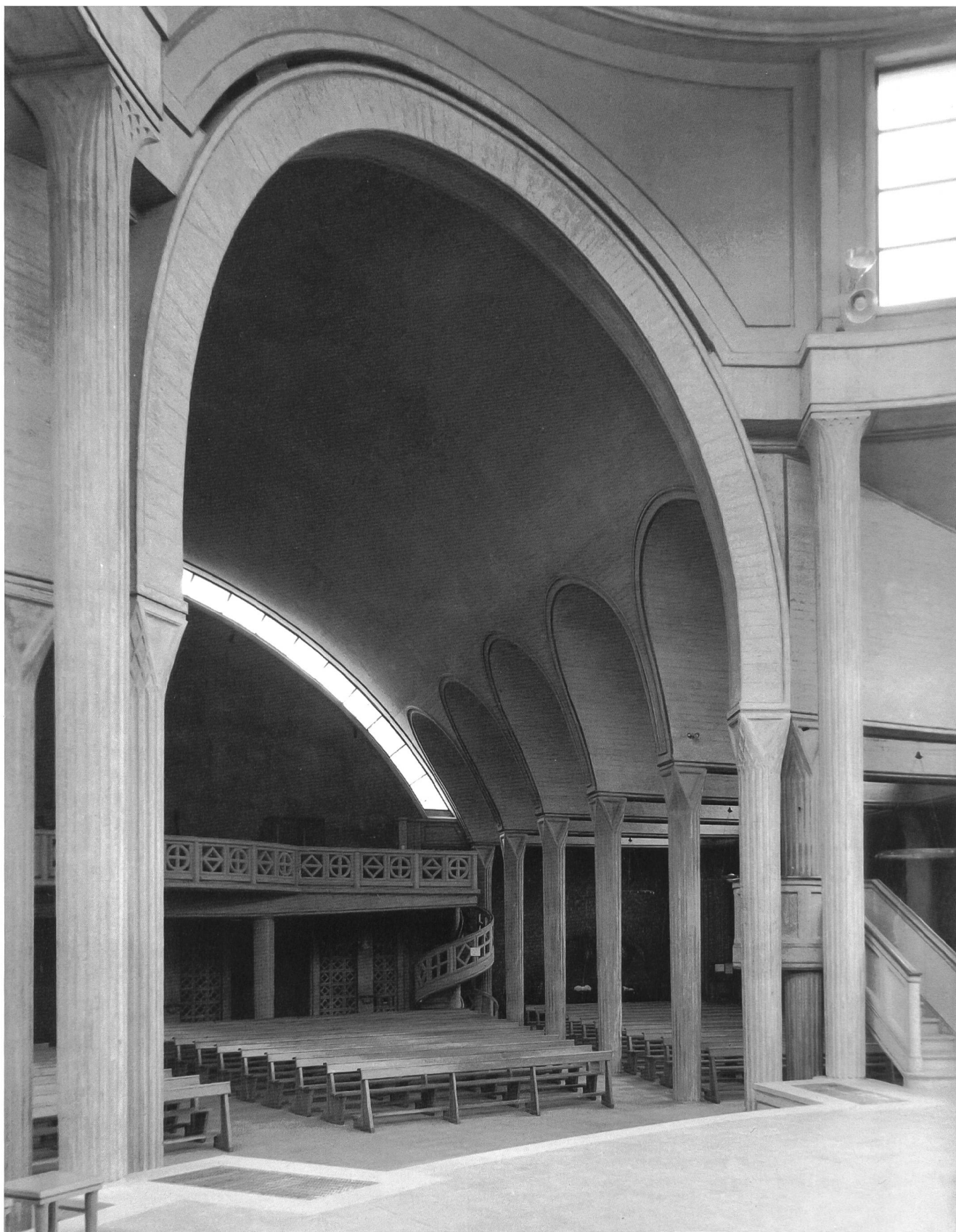
Fig. 2 L'arc de triomphe, vu du chœur, en 1953. – Véritable tour de force, cet arc ne soutient rien. Il affirme le parti structurel et masque la jonction aléatoire entre la nef en éventail et le chevet circulaire. Son développement dans l'espace, reliant l'axe de la colonnade de la nef au segment d'arc du tambour de la coupole, reste une démonstration spectaculaire des potentialités formelles du béton armé.
