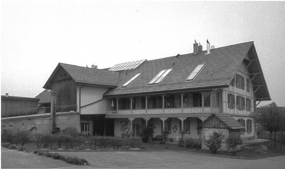
Abb. 5-7 Das Bauernhaus «Quelle» nach dem Umbau: Südansicht Wohnteil, Südansicht und Fassadenausschnitt Scheune (1997).
