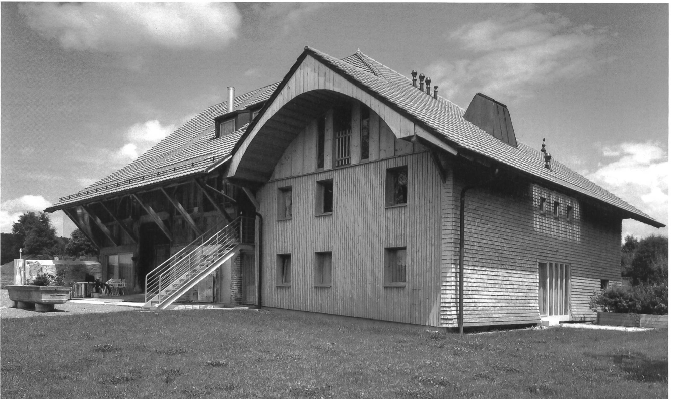
Fig. 32-33 Sâles, la maison Monney après les travaux, 1996.
