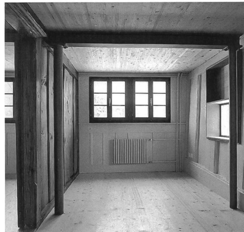
Fig. 18 L'ancien logis, chambre côté cour: conservation des cloisons et de l'ancien fourneau.
