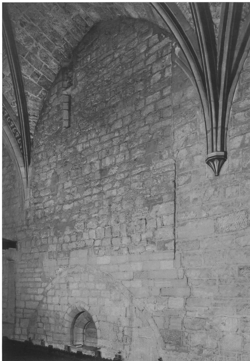
Fig. 4 Mur nord de la travée ouest du chœur. Dans la partie inférieure, traces de l'arc formeret de la voûte d'ogives antérieure à 1297 et baie en tiers-point de la même époque, partiellement cachée par les stalles.
