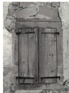
Fig. 28 Façade nord-ouest, porte d'entrée factice, 1787-1789.
