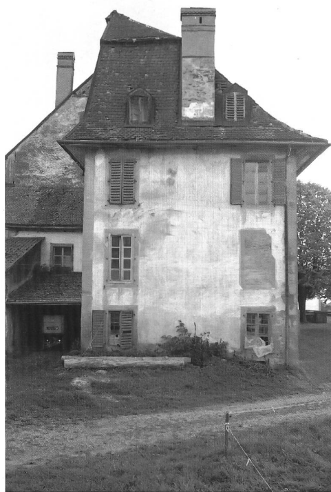
Fig. 25 Façade nord-est avec agrandissement des années 1787-1789.
