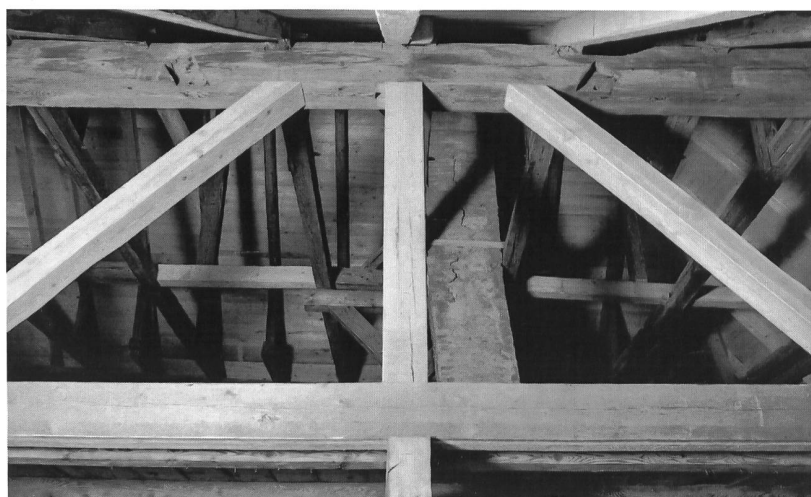
Fig. 2 Des poutres triangulées ont été insérées dans la structure pour renforcer les pannes intermédiaires sous-dimensionnées et décharger la façade pignon en reportant les charges sur les façades longitudinales.
