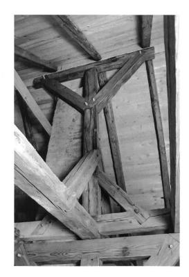
Fig. 6 Suite à la déformation de la charpente, une partie de la panne faîtière d'origine a été remplacée et soutenue par un poteau. Ce dispositif de renforcement a été conservé et la panne faîtière doublée.
