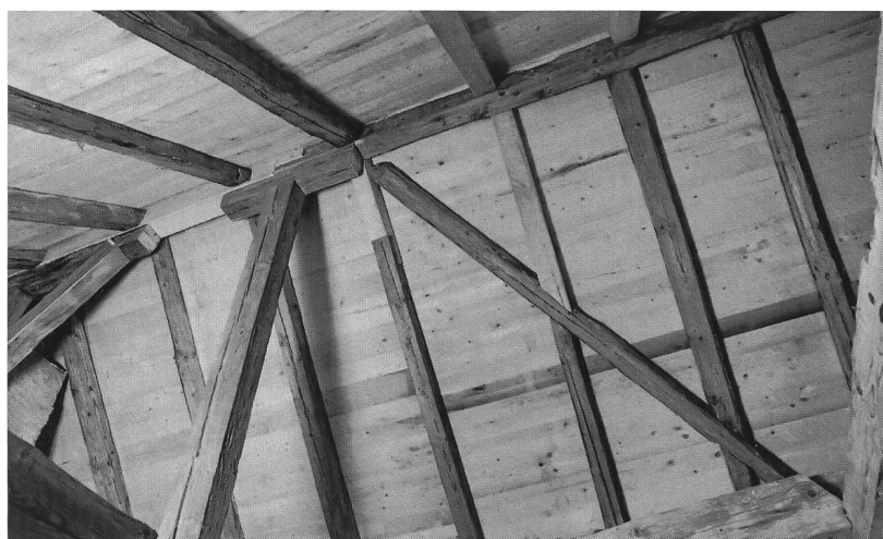
Fig. 4 Le doublage des chevrons sur leur face supérieure a permis de conserver en les renforçant des pièces qui auraient sinon dû être remplacées.
