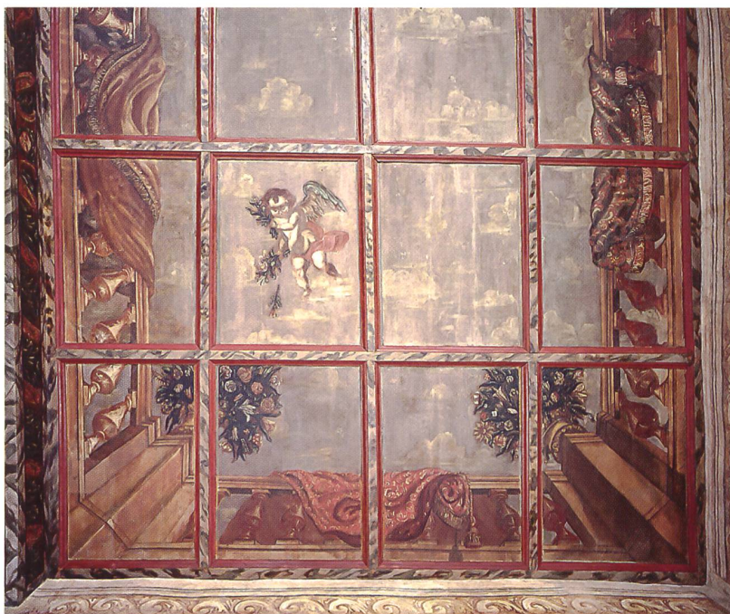
52 Détail du petit plafond (après restauration)
