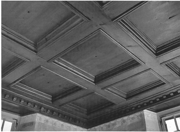
42 Détail du plafond de la chambre du prieur, 1583, réutilisé en 1683
