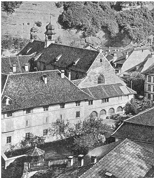
40 Photo Lorson. Blick auf den ehem. Gefängnishof und den Portikus vor der Neugestaltung 1919 ( Fribourg artistique 1905).
