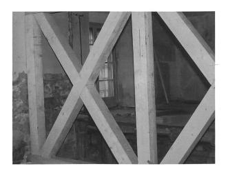
8 Un pan de bois triangulé prenant la place d'une ancienne cloison démolie au début du siècle a permis de supprimer une poutre métallique à l'étage inférieur
