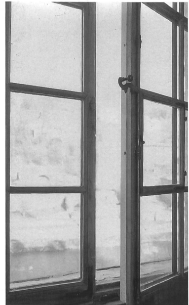
11 Les fenêtres anciennes ont été conservées et doublées d'un guichet extérieur
