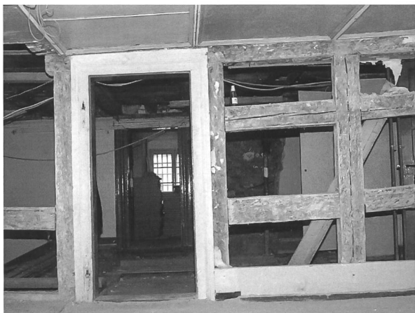
6-7 Un colombage obsolète du point de vue statique a été remplacé par un pan de bois triangulé supportant la structure de l'étage supérieur et déchargeant la poutraison de l'étage inférieur
