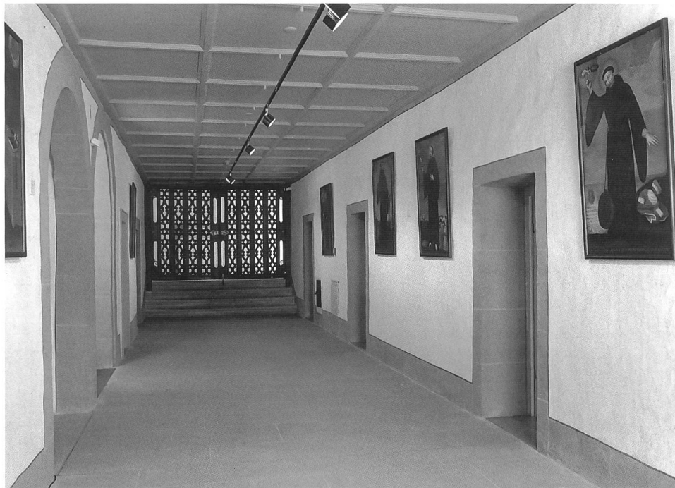
12-13 Pour accompagner la restitution du décor mural du couloir du rez-de-chaussée, le plafond en plâtre a été remplacé par un plafond à caissons reconstitué sur la base d'anciens couvre-joints découverts lors de la démolition
