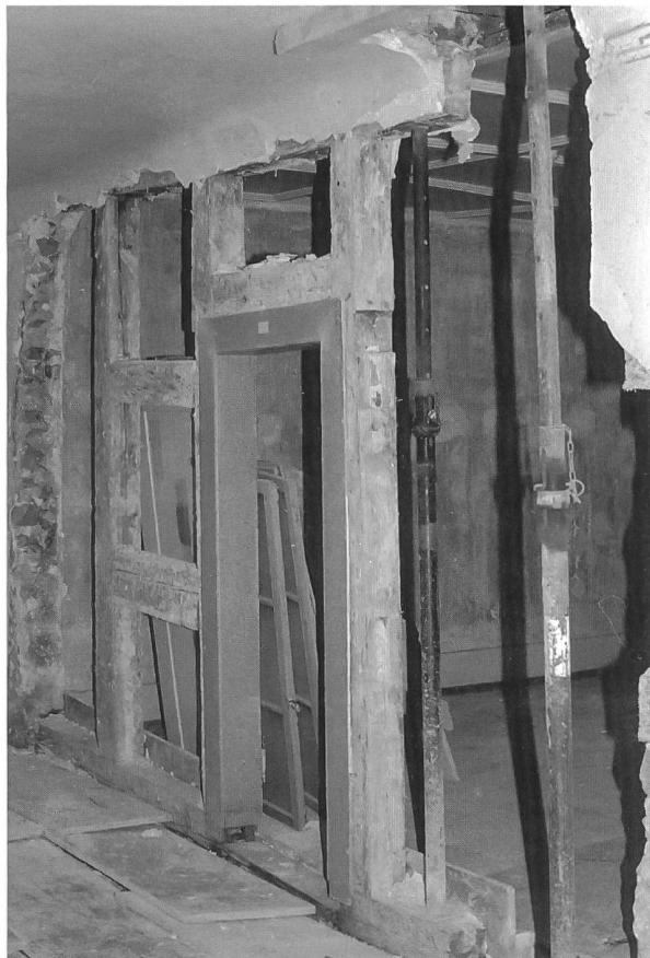
4 L'installation de poêles et de canaux de fumée a endommagé la structure des colombages
