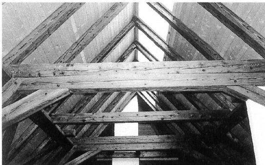
5 Bandeau de tuiles de verre éclairant les combles.
