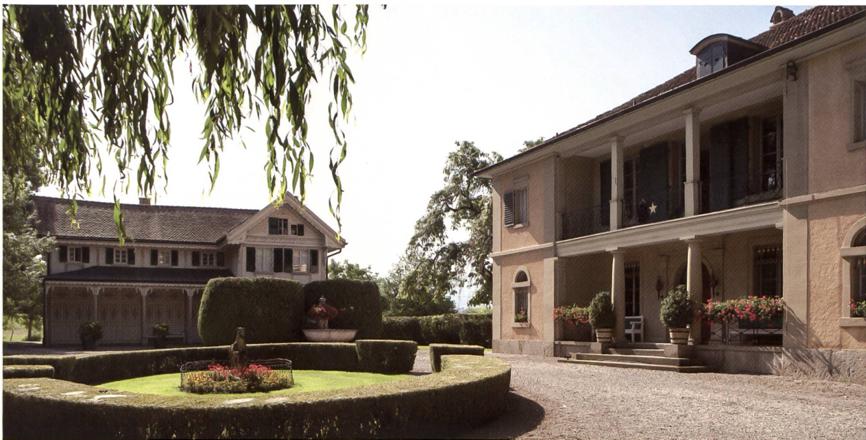
DER EINGANGSHOF MIT DEM HERRENHAUS UND DER DÉPENDANCE, DIE ZIMMERMANNMEISTER JEAN OBERSON 1862 FÜR FRANÇOIS DE WECK-DE SURBECK BAUTE.
