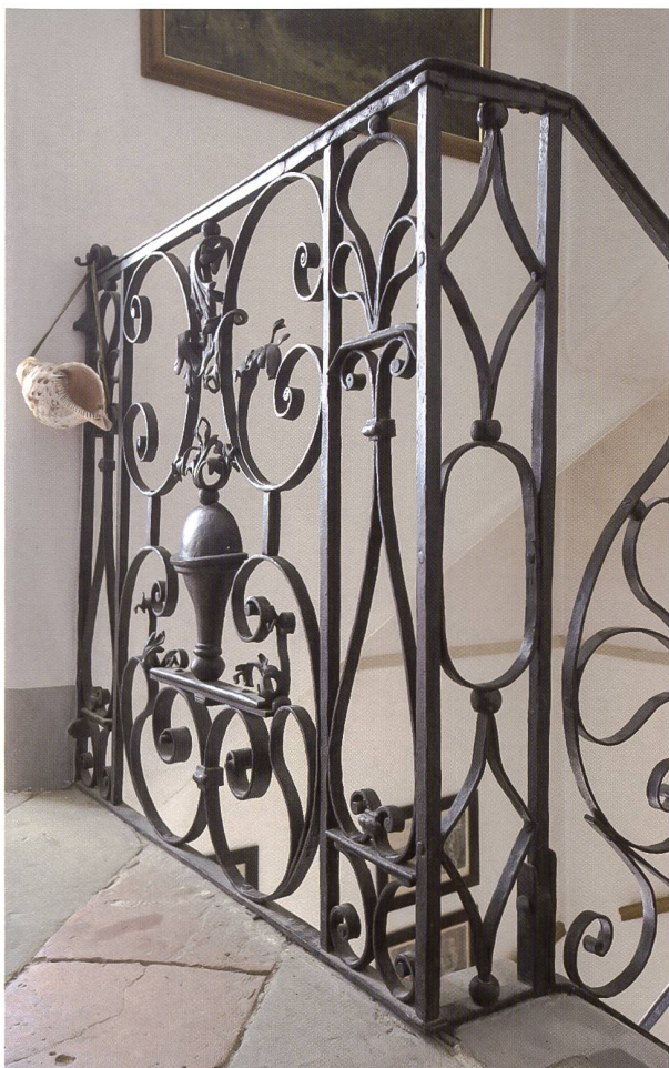
DAS SCHMIEDEEISERNE GELÄNDER DES TREPPENHAUSES DATIERT AUS DER BAUZEIT.
