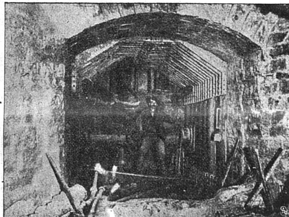
Armatures de fer placées aux endroits peu résistants.
