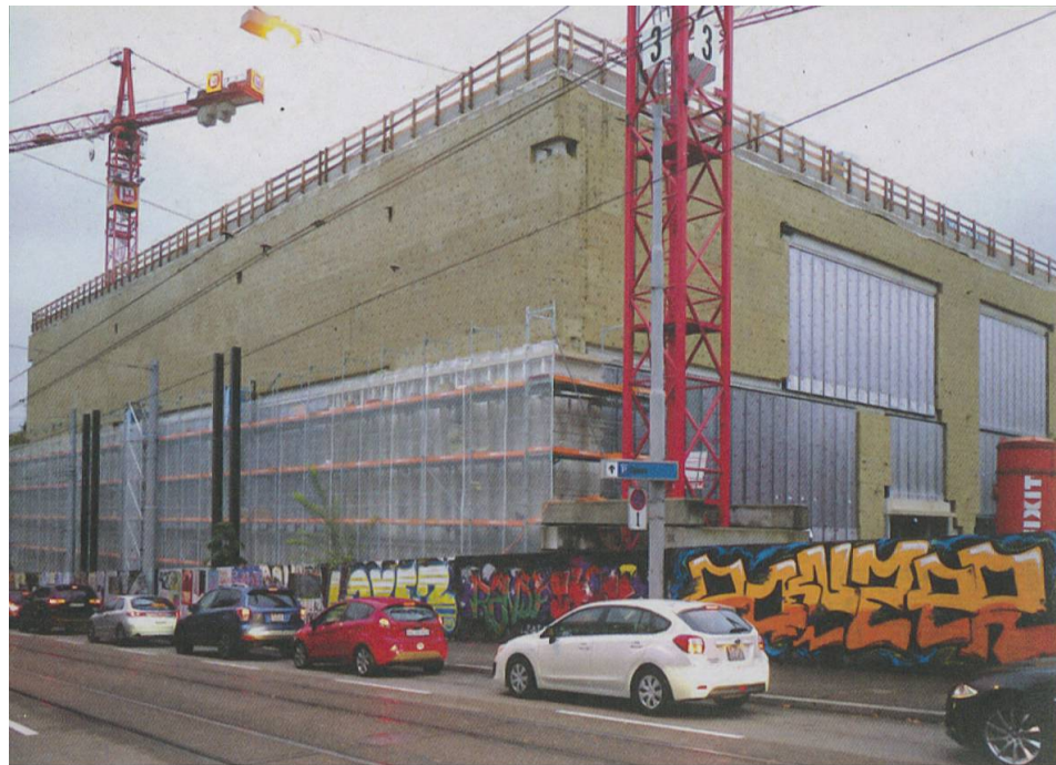
Der Erweiterungsbau des Kunsthhauses Zürich in Steinwolle gekleidet, kurz vor der Montage der Kalksteinfassade
