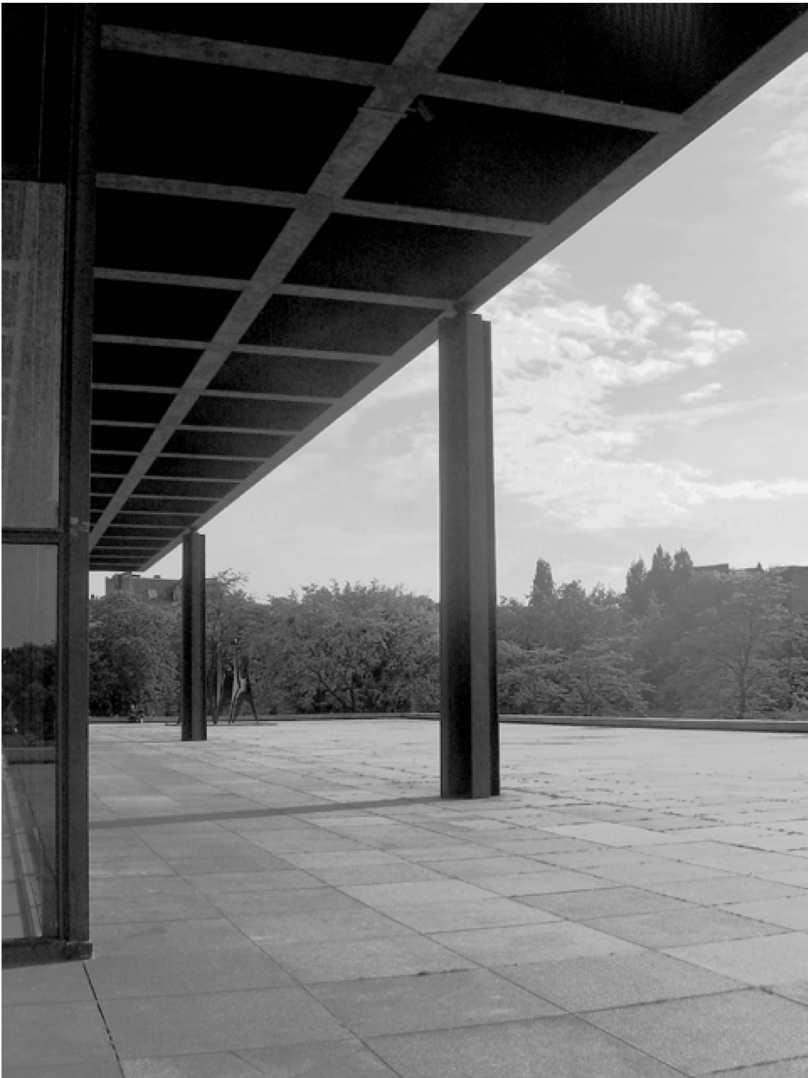
Mies van der Rohe, Neue Nationalgalerie Berlin, Oberes Plateau mit Kreuzstahlstützen
