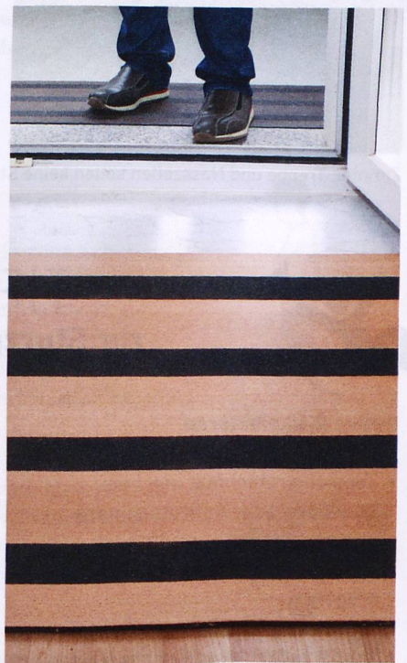
Schwellen können mit einer Rampe behoben werden. Foto: Fotolia
