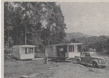
Vorfabriziertes, transportables Wohnhaus, das in zwei Hälften angefertigt wird
