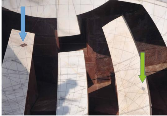
Abbildung 5: Blick in eines der Jaiprakash Yantras in Jaipur. Verschiedene Skalen erlaubten die Bestimmung der Position eines Objekts, des Datums oder der Zeit. Eine Metallscheibe mit einem Loch bildet den Referenzpunkt im Zentrum der Halbkugel (blauer Pfeil). Der Schatten (grüner Pfeil) ermöglicht die genaue Ablesung. Die Astronomen bewegten sich in den Aussparungen.
