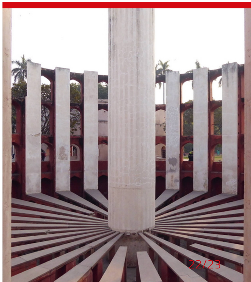
Abbildung 4: Das Innere eines der zwei Rama Yantras. Die Säule in der Bildmitte ist der Gnomon. Die gewiesenen Flächen waren mit Skalen versehen. Die Position eines Objekts wurde durch Anvisierung des Objekts, welches sich an der Oberkante des Gnomons befinden musste, bestimmt.
