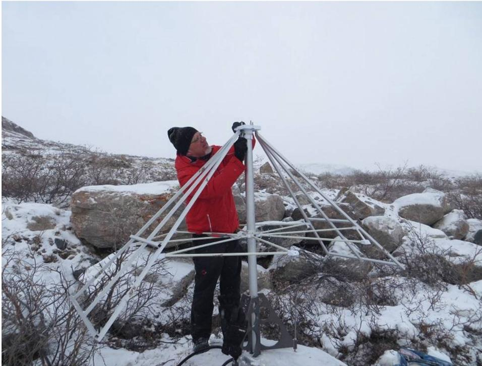
**LWA-Antenne, montiert auf einem Felsen in Grönland. Rentiere sollen die Antenne nicht als Kratzbürste missbrauchen. Die Gewindestangen zur Befestigung der Montierung wurden mit speziellem, kältetauglichem Kleber in vorgebohrte Löcher im Felsen eingeklebt. Bei  $-20^{\circ}\text{C}$  war die Bastelei an der Antenne für Christian Monstein gewöhnungsbedürftig und nicht trivial.**
