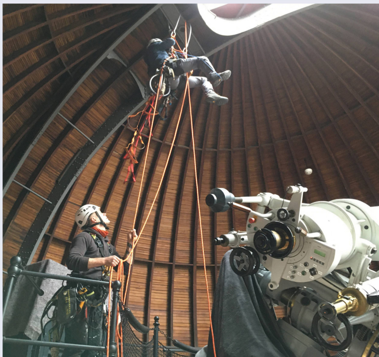
In einer aufwändigen Kletter-Aktion konnten die Lager neu gefettet und wieder richtig justiert werden.
