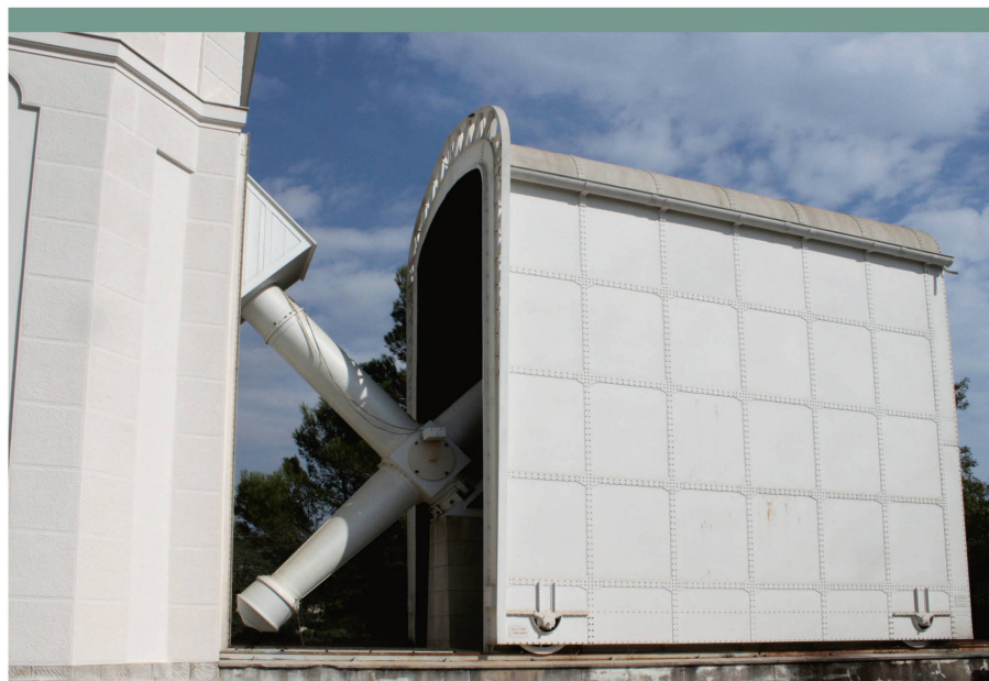
Abbildung 9: Die sich hier gerade öffnende Schutzhütte bewahrt die frei stehenden Teleskopteile des Coudé-Refraktors vor den Unbilden der Witterung.
