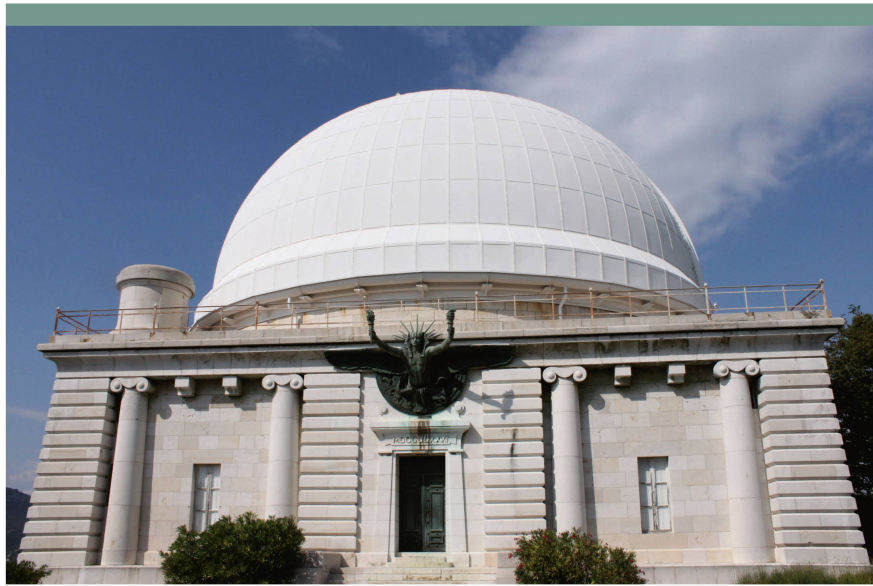
Abbildung 2: Die «Coupole Bischoffsheim», der Schutzbau des Grossen Refraktors, ist ein Werk des Architekten Charles Garnier und erinnert durch die klassizistische Gestaltung ihrer Frontseite an einen antiken Tempel. Die Stahlkuppel mit einem Durchmesser von 24 Metern entwarf der Ingenieur Gustave Eiffel . Als technische Neuerung war sie schwimmend gelagert ( coupole flottante ), um bei geringerer Reibung eine leichtere Drehbarkeit zu erreichen.
