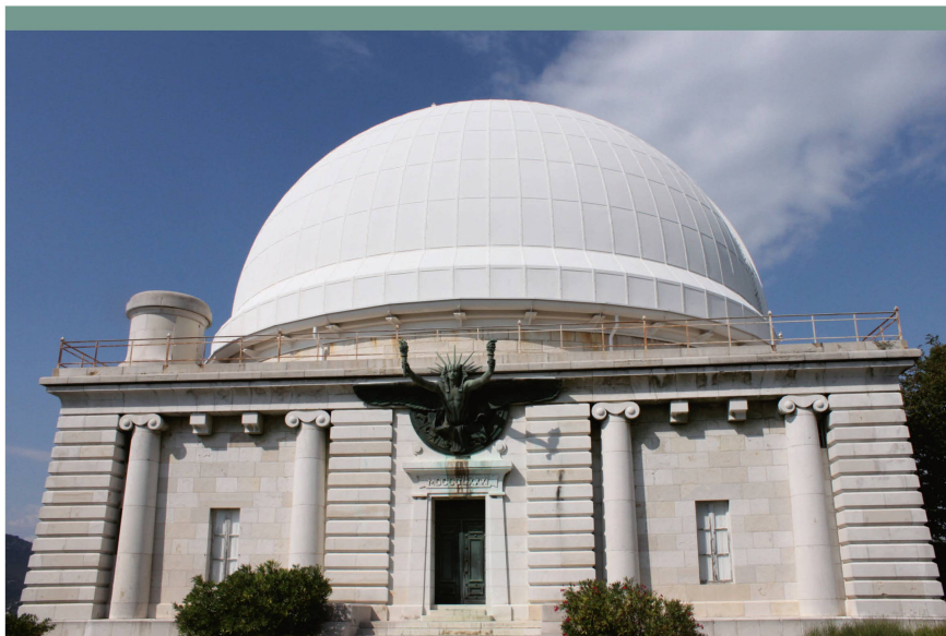
Abbildung 2: Die «Coupole Bischoffsheim», der Schutzbau des Grossen Refraktors, ist ein Werk des Architekten Charles Garnier und erinnert durch die klassizistische Gestaltung ihrer Frontseite an einen antiken Tempel. Die Stahlkuppel mit einem Durchmesser von 24 Metern entwarf der Ingenieur Gustave Eiffel . Als technische Neuerung war sie schwimmend gelagert ( couple flottante ), um bei geringerer Reibung eine leichtere Drehbarkeit zu erreichen.
