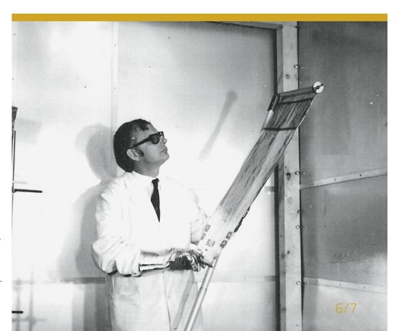
Abbildung 1: Johannes Geiss testet 1971 in der Klimakammer der Contraves in Zürich das Funktionieren des für Apollo 16 modifizierten Sonnenwindsegels.
