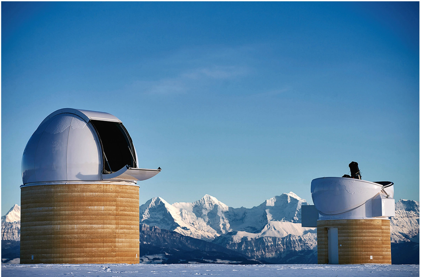
Abbildung 2: Die beiden neuen Kuppelbauten des Observatoriums Zimmerwald mit 5.3 Metern (links) und 4.5 Metern (rechts) Durchmesser.
