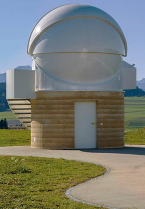
äquate Materialisierung für das Rurale abzubilden fand das Büro im Material Stampfbeton, der eine Wiederaufnahme alter Verarbeitungstechniken, kombiniert mit neu entwickelten Anschlussdetails, zur Folge hatte.
