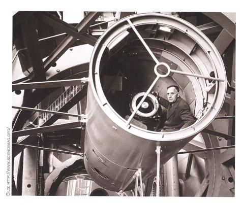
Abbildung 4: Edwin Hubble bei den Justierungsarbeiten im «Beobachterkäfig» des Hale Teleskopes auf dem Palomar Mountain. Die Konstruktion ist derart massiv gebaut, dass ein Mensch problemlos im Sekundarfokus arbeiten kann.
