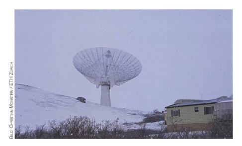
Abbildung 3: Die 32-Meter-Parabolspiegel mit der Radarstation (rechts). Horrend starke Radio-Signale mit 500 Mega Watt bei 1260 MHz werden in die lonosphäre gestrahlt und die Echos gemessen und studiert. Nachts leuchtet ein grüner Laser weit in den Himmel. Der grosse Radar-Spiegel, der grüne Laser und die sich bewegenden Polarlichter hinterlassen einen tiefen, unvergesslichen Eindruck.
