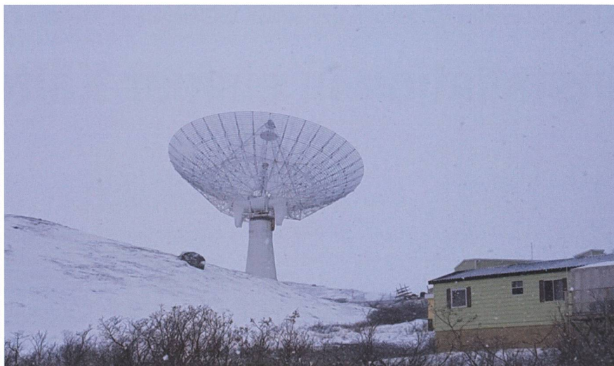
Abbildung 3: Die 32-Meter-Parabolspiegel mit der Radarstation (rechts). Horrend starke Radio-Signale mit 500 Mega Watt bei 1260 MHz werden in die Ionosphäre gestrahlt und die Echos gemessen und studiert. Nachts leuchtet ein grüner Laser weit in den Himmel. Der grosse Radar-Spiegel, der grüne Laser und die sich bewegenden Polarlichter hinterlassen einen tiefen, unvergesslichen Eindruck.
