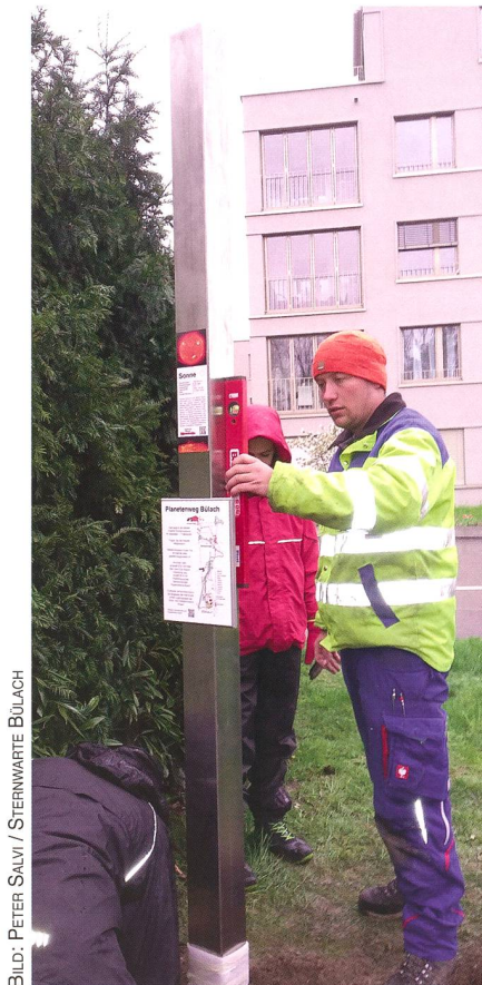
Abbildung 2: Ist alles im Lot? MICHAEL BIERI, Metallbauer, prüft, ob der neue Pfahl für die Sonne auch wirklich gerade steht.
