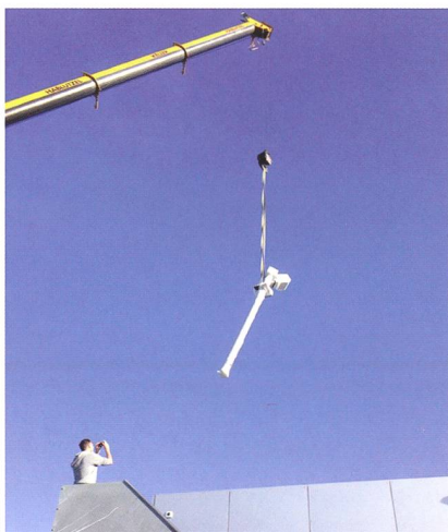
Abbildung 2: Im April 2015 wird der Heliostat auf das Dach des Planetariums gehievt.
