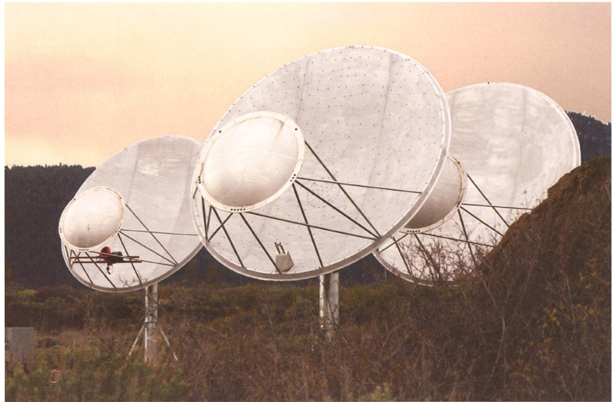
Das Allen Telescope Array in Nordkalifornien befindet sich im Bau. Nach seiner Fertigstellung wird es aus 350 einzelnen 6.1m-Antennen bestehen und das bisher einzige Grossteleskop sein, welches ausschliesslich für die SETI-Forschung zur Verfügung steht. Betrieben wird das Instrument vom privaten SETI-Institut und der Universität Berkeley. (Bild: Seth Shostak, SETI-Institut)
