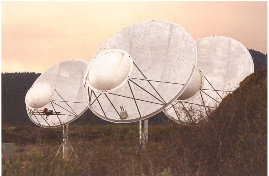
Das Allen Telescope Array in Nordkalifornien befindet sich im Bau. Nach seiner Fertigstellung wird es aus 350 einzelnen 6.1m-Antennen bestehen und das bisher einzige Grossteleskop sein, welches ausschliesslich für die SETI-Forschung zur Verfügung steht. Betrieben wird das Instrument vom privaten SETI-Institut und der Universität Berkeley. (Bild: Seth Shostak, SETI-Institut)
