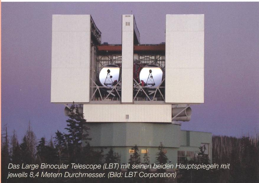
Das Large Binocular Telescope (LBT) mit seinen beiden Hauptspiegeln mit jeweils 8,4 Metern Durchmesser. (Bild: LBT Corporation)
